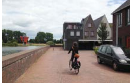
Rijbaan gebakken klinkers met voetgangersstrook
