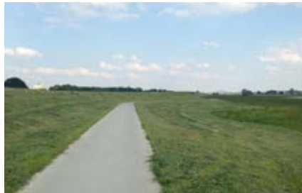
Voetpad beton langs het water
